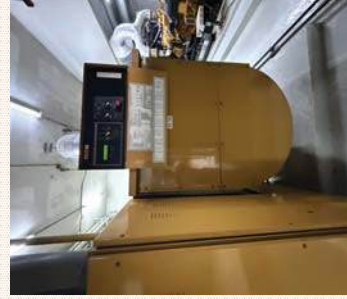
6.) ทำการตรวจเช็คแบตเตอรี่และทดสอบการใช้งานของเครื่องกำเนิดไฟฟ้าสำรอง
