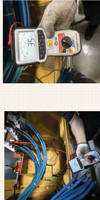
5.) ทำการวัดค่าความต้านทานของขดลวด
